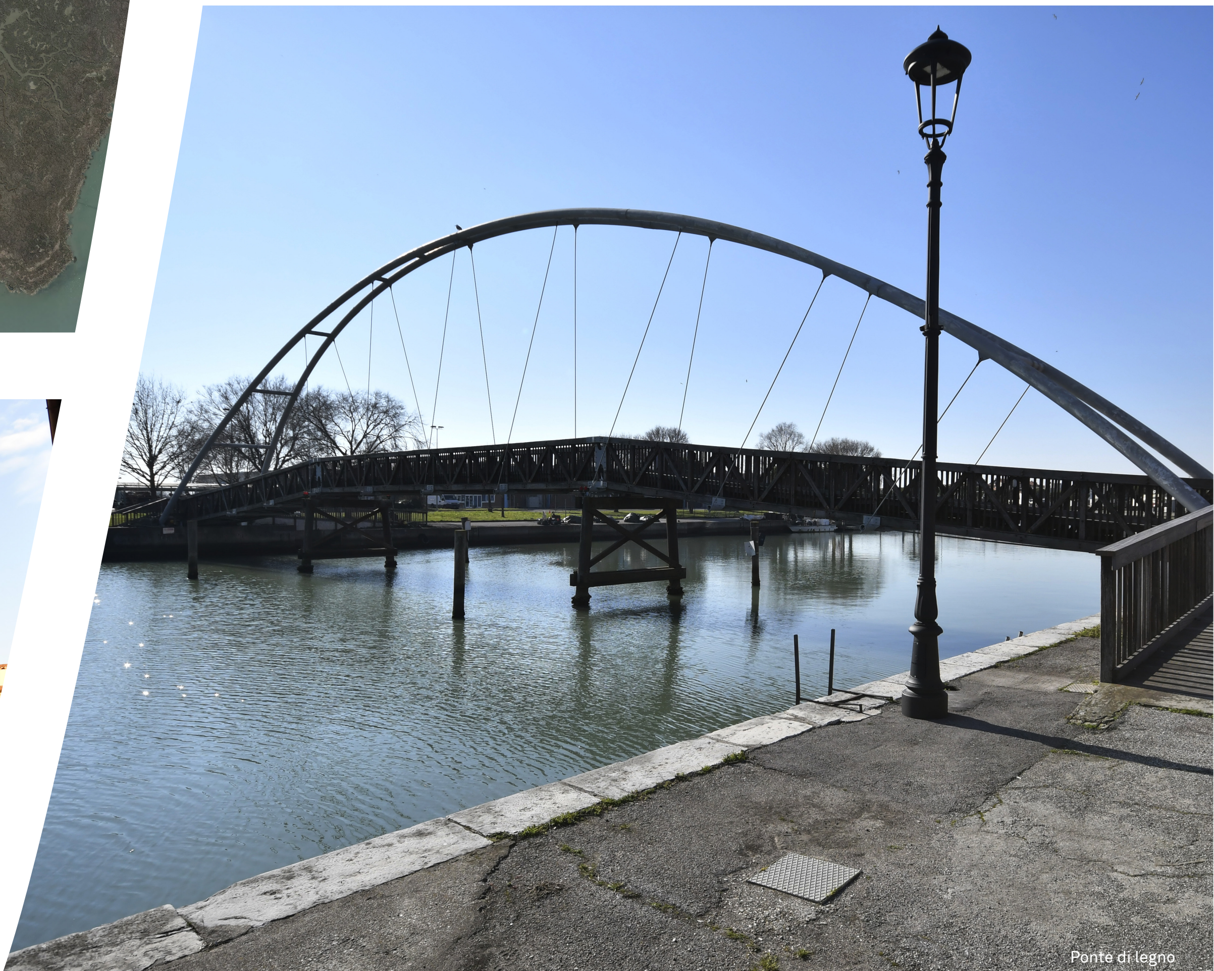
Ponte di legno
