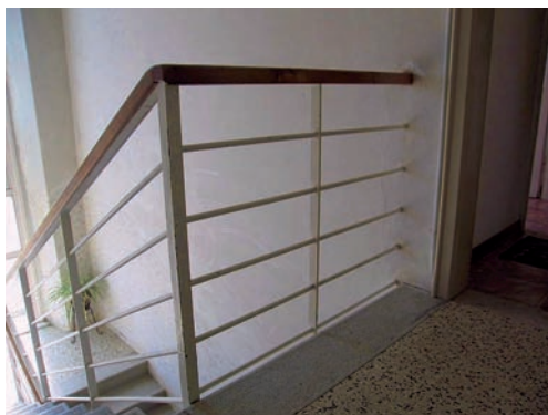
19.2 - Esempio di parapetto che permette una facile arrampicata da parte di bambini
