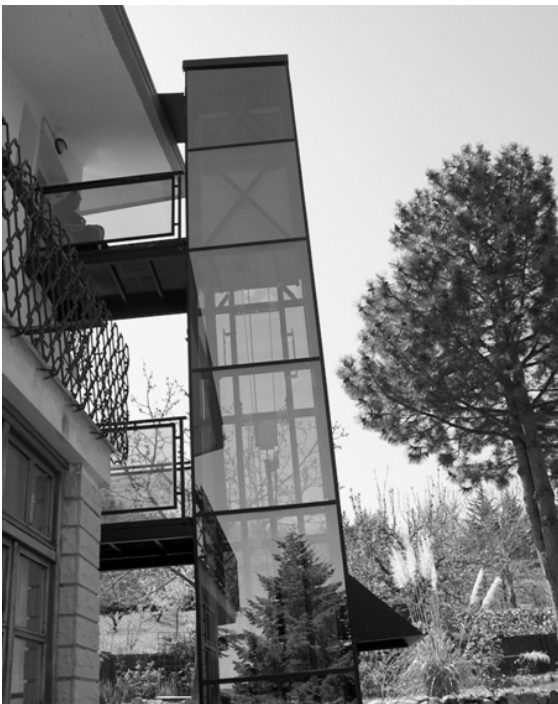
Un ascensore leggero a tre fermate
