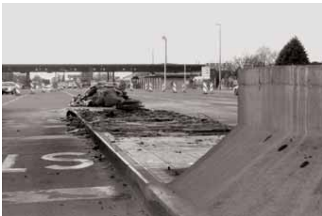
La demolizione del valico confinario a Sant'Andrea-Vrtojba ( www.goriziaoggi.info )
