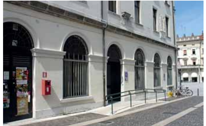
Municipio di Monfalcone, rampa d'accesso laterale
